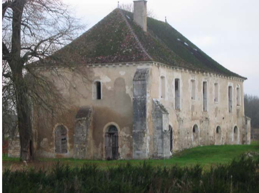
Quincy – Vue du pignon sud et de la façade est du bâtiment des moines. Etat en 2004.
