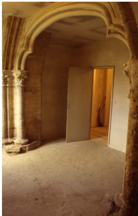
Fig. 4. Sens, ancienne abbaye Saint-Paul. Ancienne baie géminée de la salle capitulaire, après travaux. Le grand arc central est une restitution moderne. Cl. DC.
