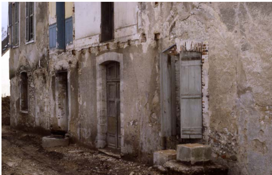
Fig. 2. Sens, rue Champbertrand, n° 100. Façade Ouest de l'ancienne maison de la fabrique Querelle-Cronier pendant travaux. Traces des arcatures murées incluses dans la maçonnerie. Cl. DC.
