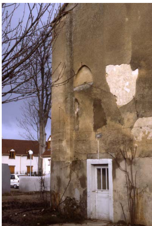
Fig. 12. Sens, ancienne abbaye Saint-Paul. Pignon sud de l'ancienne fabrique Querelle-Cronier, avant travaux. Cl. DC.
